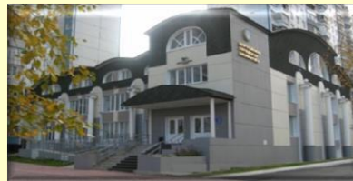
Объекты библиотечного обслуживания
